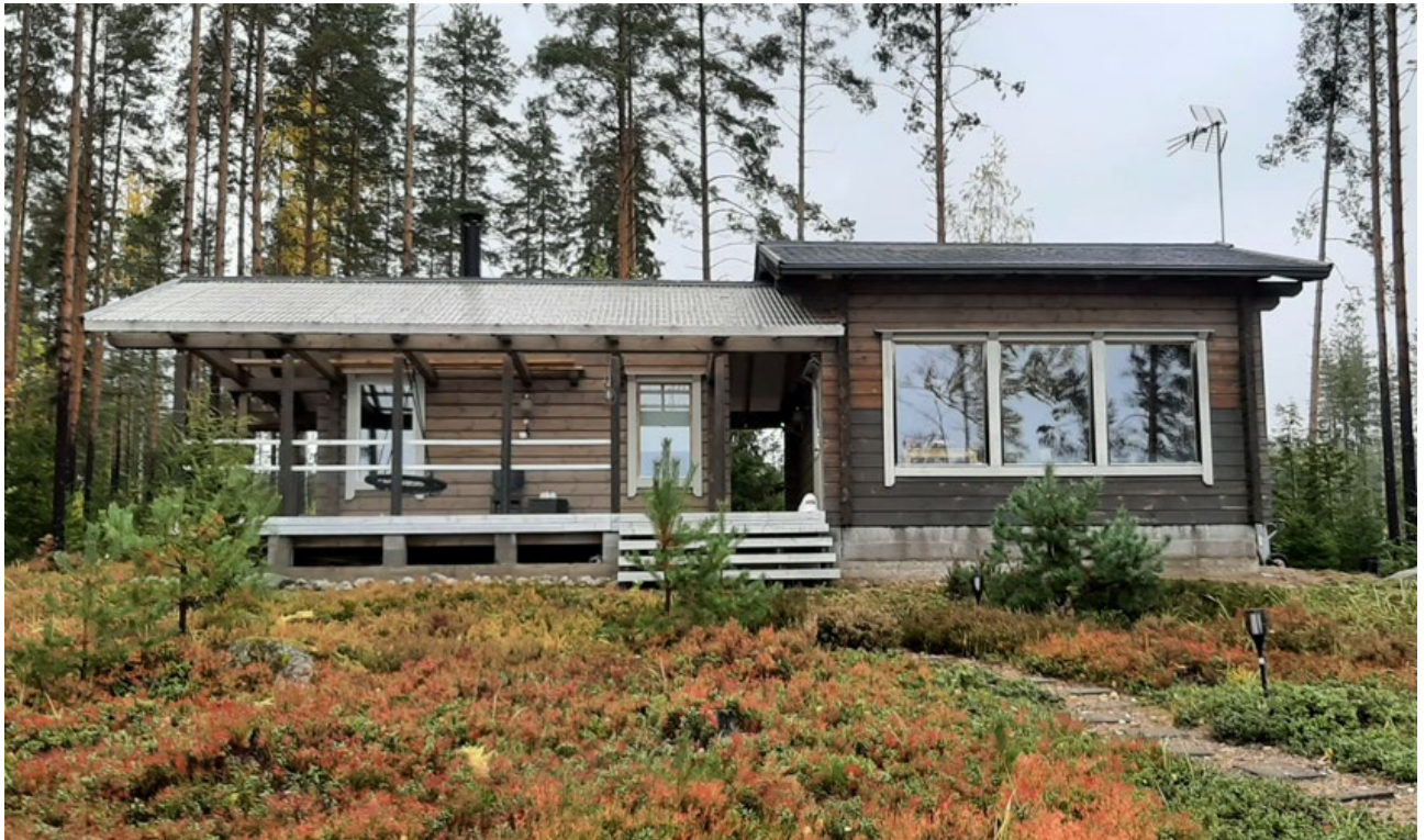
Kuva 2, Muikkulan tilan lomarakennus rannan puolelta kuvattuna.
